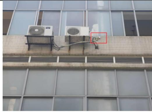
图4.2-12氯化氢泄露报警仪
