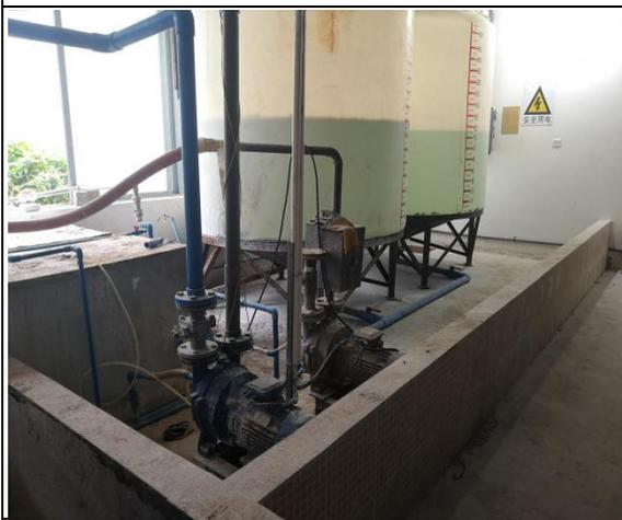
图4.2-3烧碱罐区围堰
