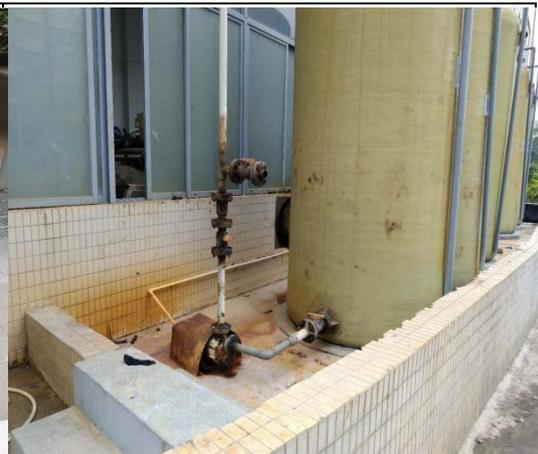
图4.2-2氯化钙罐区围堰
